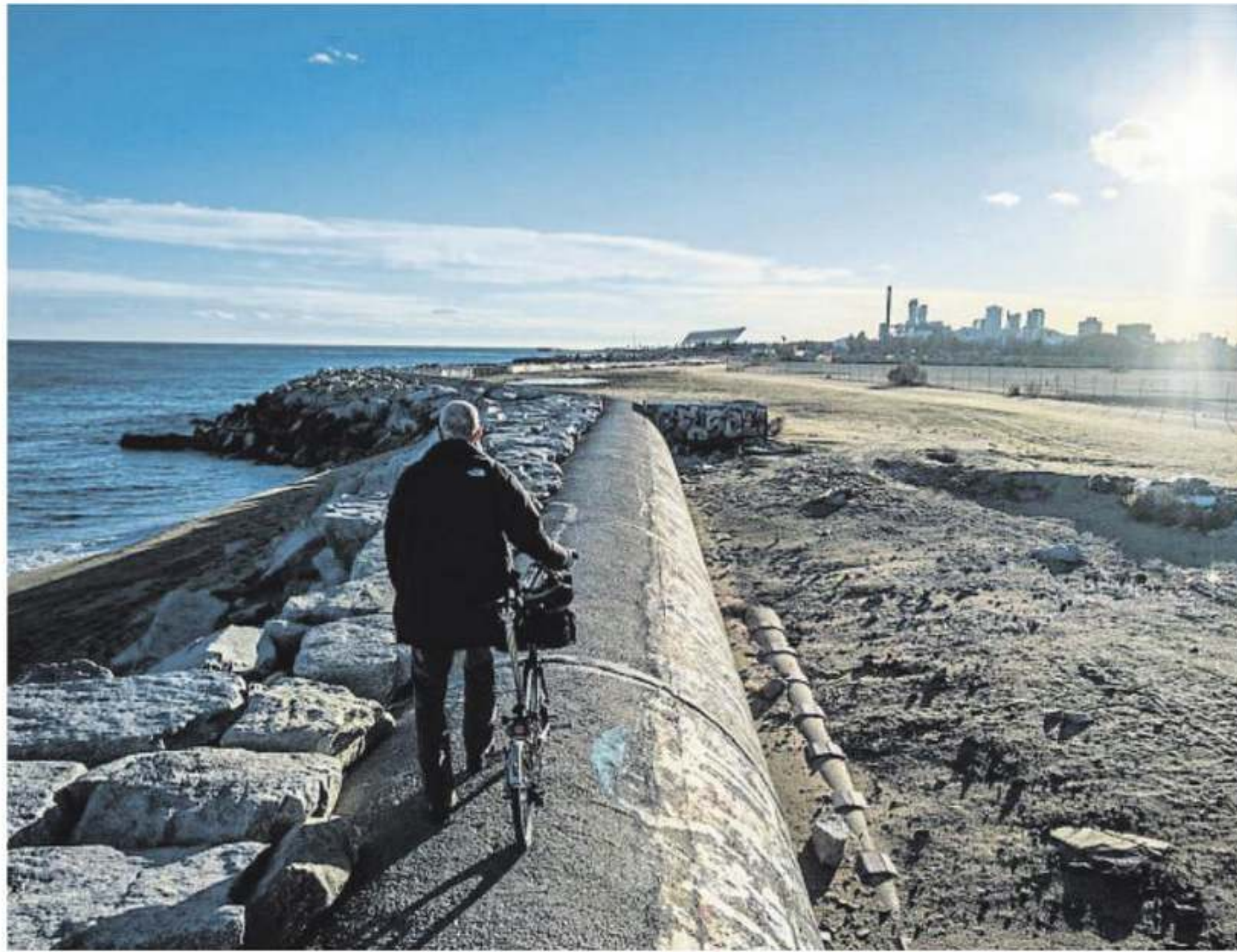
La protección del colector de Llevant, que transcurre por el litoral, se ha reforzado con escolleras
